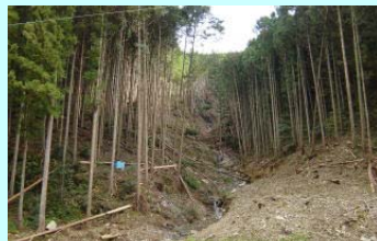
東海豪雨による「沢抜け」
