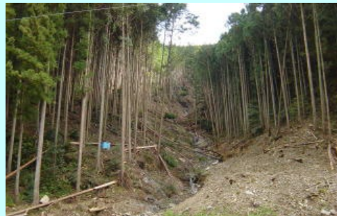
東海豪雨による「沢抜け」
